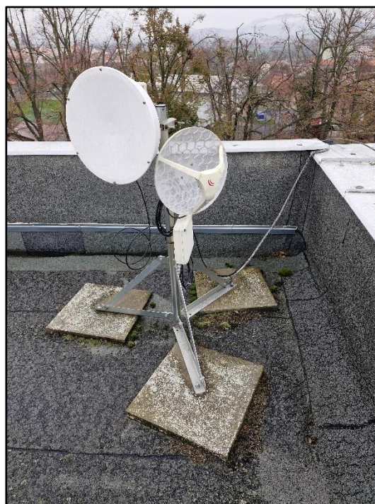
Obr. 2 a 3 – pohled na zaatikový žlab a konstrukci antény na střeše „A“
