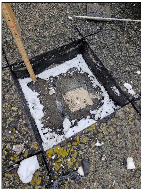
Obr. 4 a 5 – pohled na vnitřní nároží a sondu do střešního pláště střechy „A“
