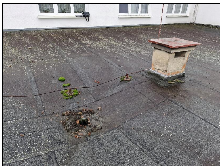
Obr. 12 - 16 – pohled střechu „C“, sondu do střešního pláště a žebřík na střechu „B“
